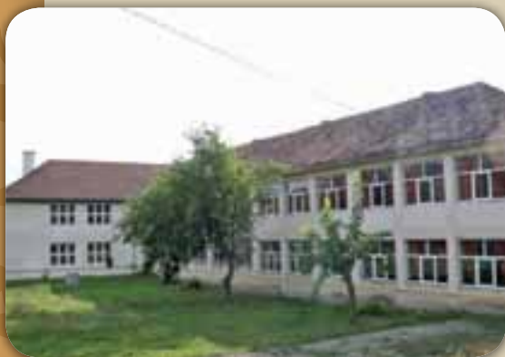
A felújított iskola
